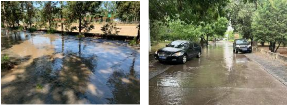
图 10 现状堤路积水
