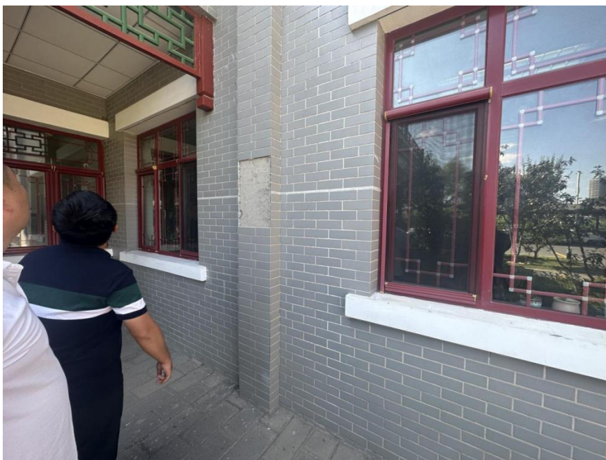
外墙墙砖原貌
