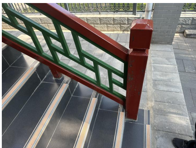
金属栏杆原貌
