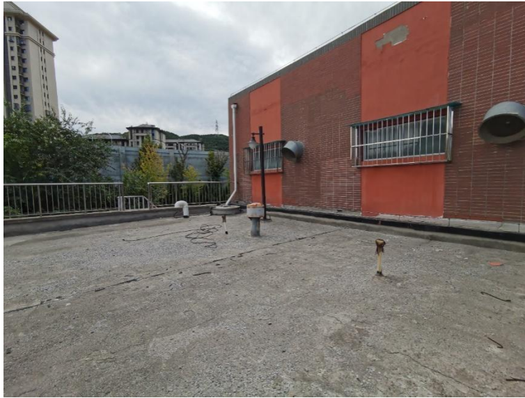
图2.15 调节水池顶部
