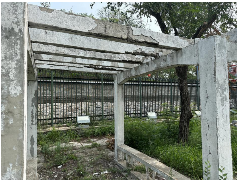
三副坝内坡平台现状
