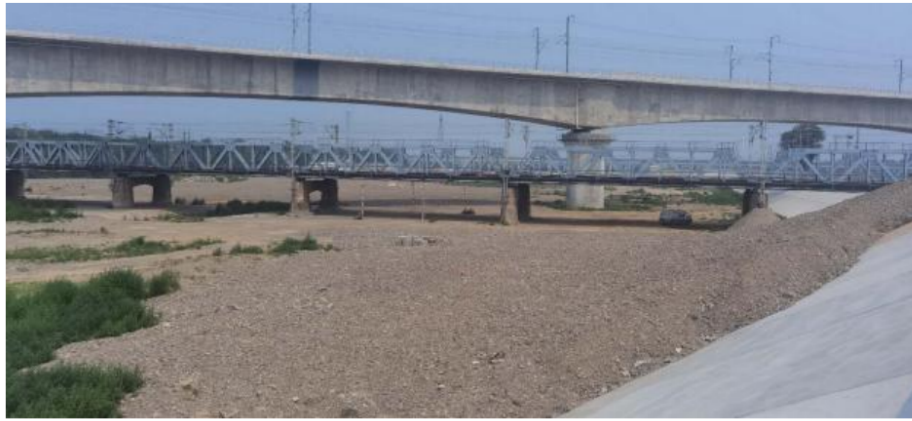
京广铁路 5 号大桥现场照片。
