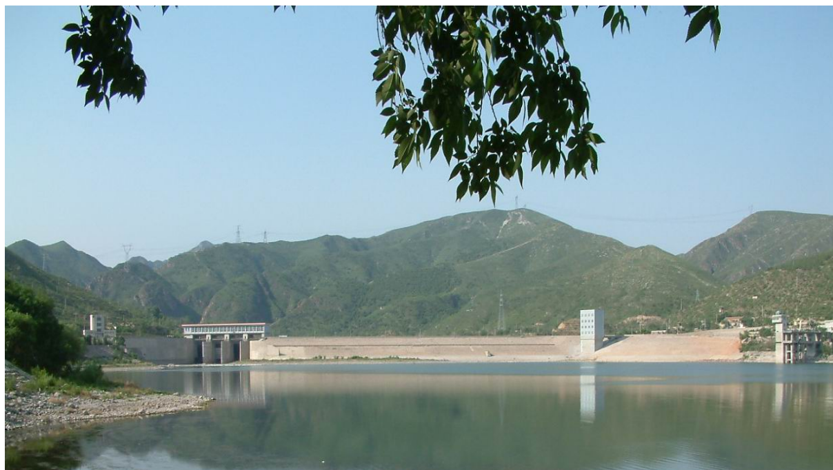
图 1-3 官厅水库枢纽工程
