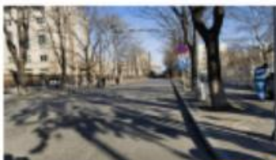
路面标线磨损、缺失
