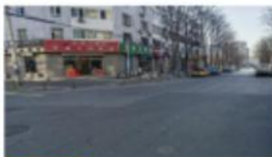
路面标线磨损、缺失
