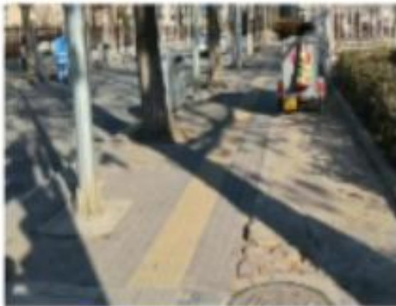
外侧硬化破损
