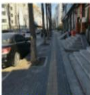
步道砖面泥土剥落现状
