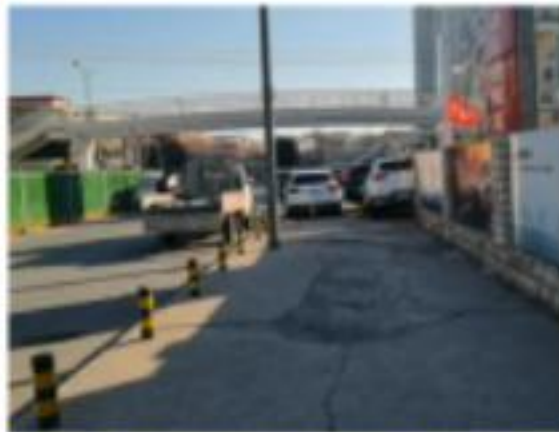
部分段落无步道、混凝土硬化破损
