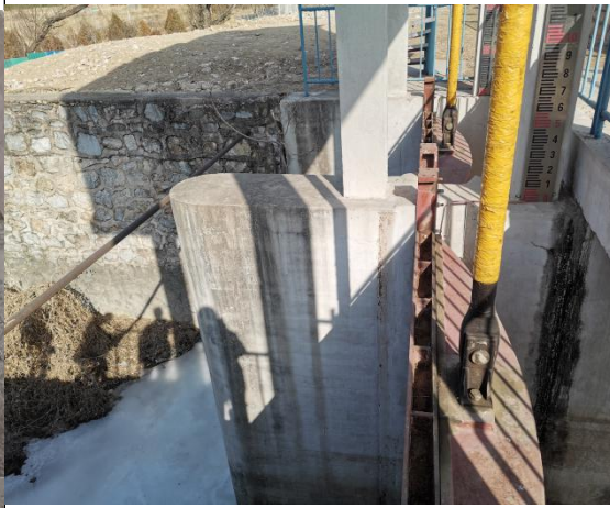
北台上进水闸闸墩现状
