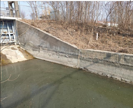
崔村泄洪闸翼墙现状
