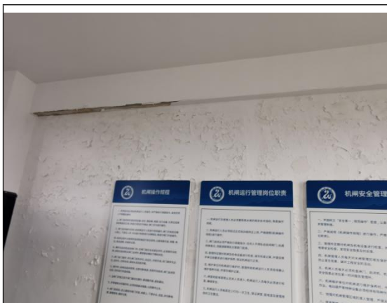
北台上倒虹吸出口闸内墙现状 (一)
