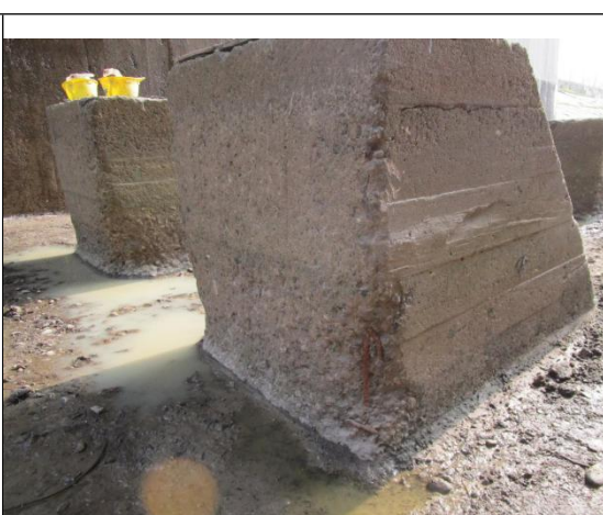
跌水节制闸消力墩现状
