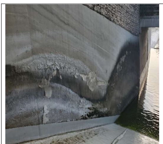
跌水节制闸翼墙现状
