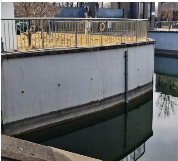
土城泄洪闸翼墙现状
