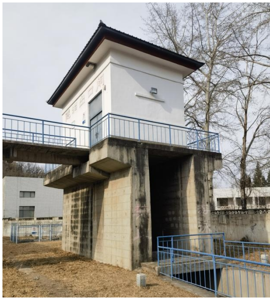
隧洞出口闸现状（一）
