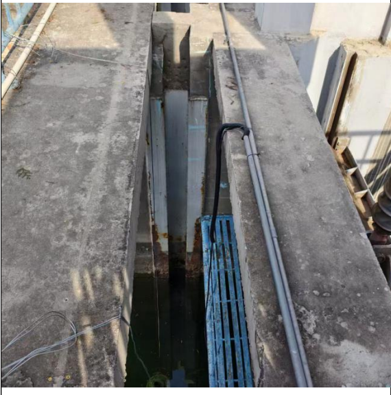
土城泄洪闸门槽现状
