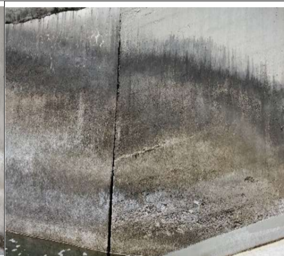
跌水节制闸翼墙现状
