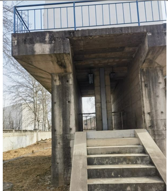
隧洞出口闸现状（二）
