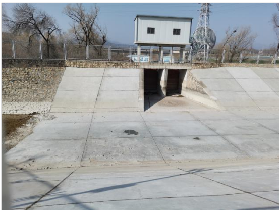
北台上进水闸现状
