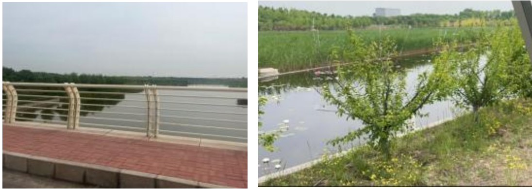
图 4-4 桥区水域周边缺少警示标识牌
