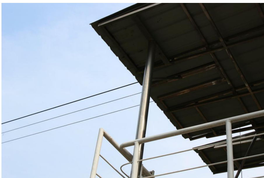
张家坟水文站缆道
