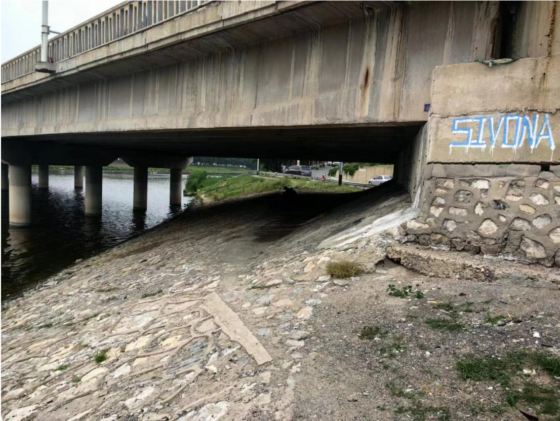
运潮减河桥下照片
