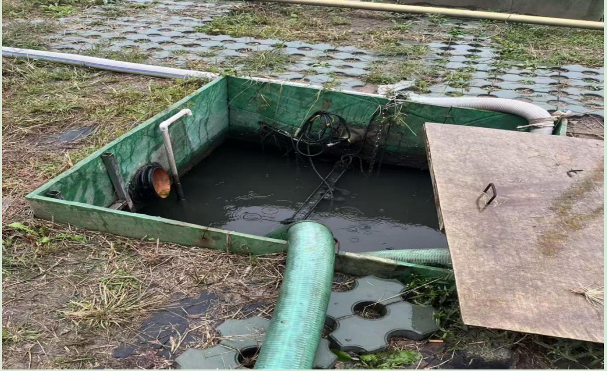
污水站现状图 1
