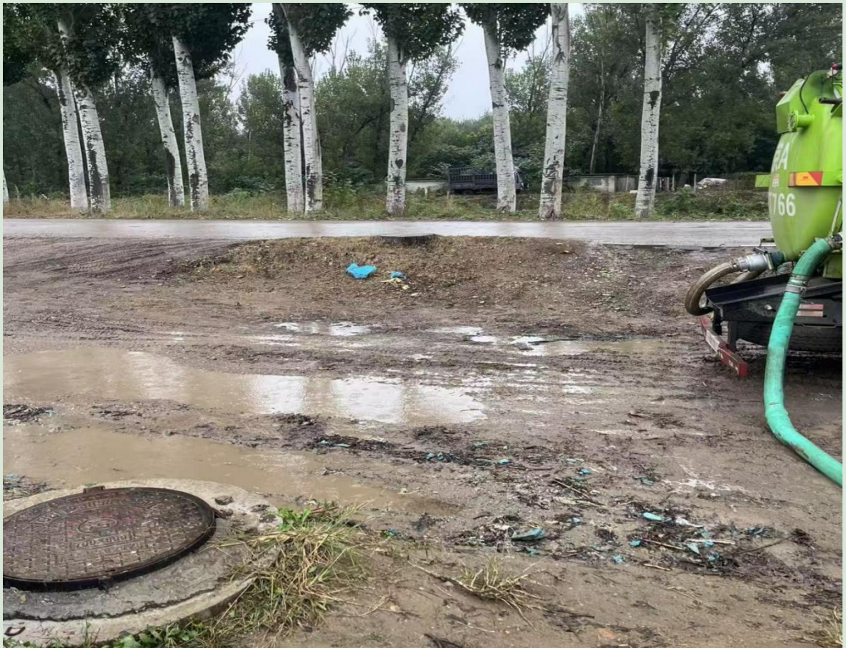
污水站现状图 2
