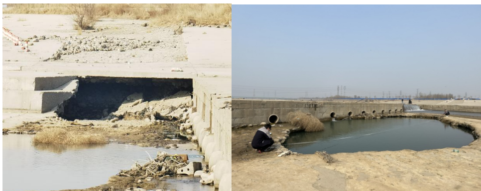
图 1-1 河道护砌冲毁陶刷
