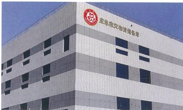
图 5 各级应急物资储备库悬挂标识示例
